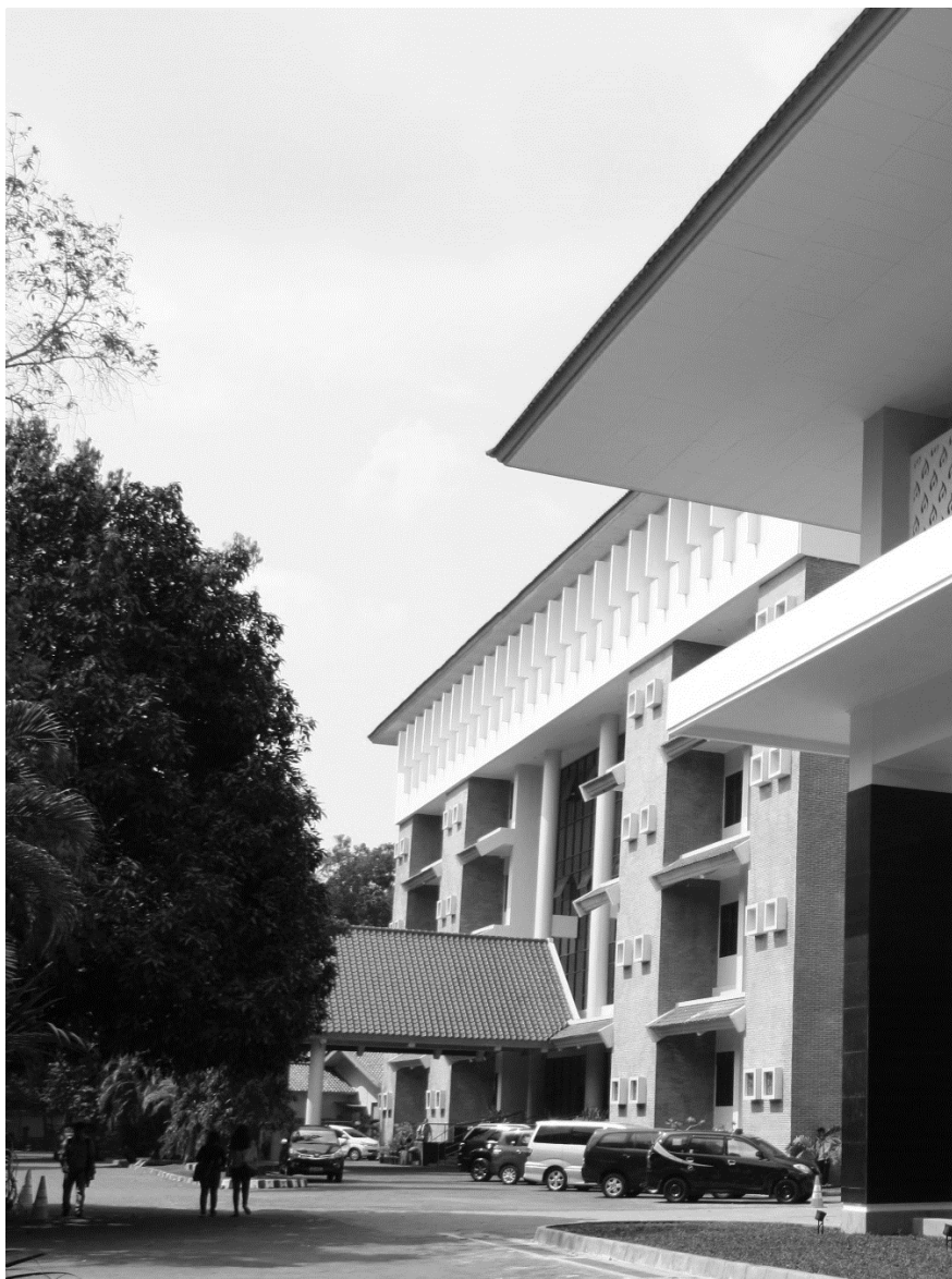
Gedung Pusat Kampus II Universitas Sanata Dharma Jl. Affandi, Depok, Sleman, Yogyakarta
